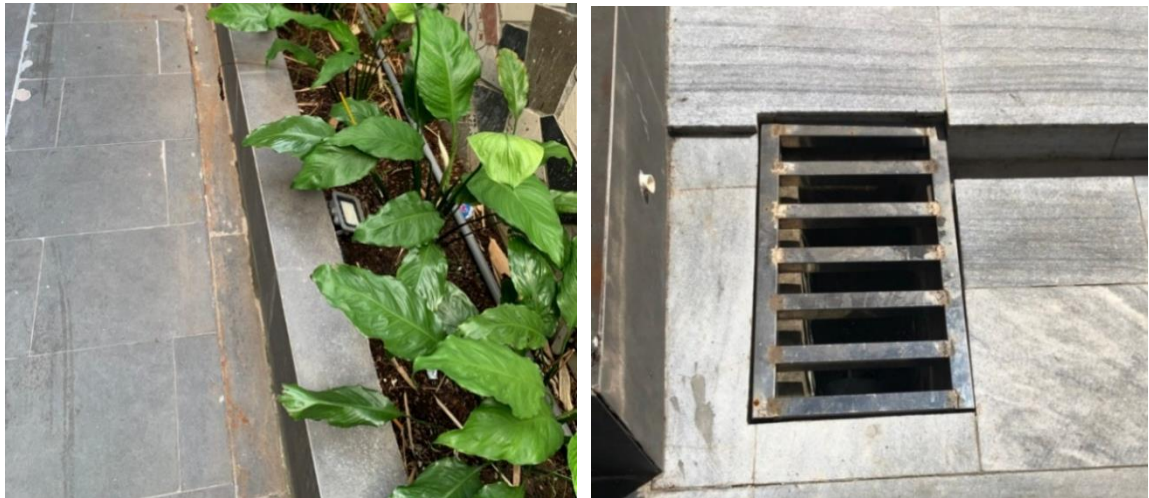
Hình 3.2. Tuyến cống BTCT có song chắn rác
